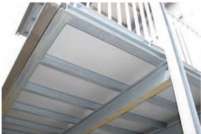
Konstrukcja wsporcza, dźwigary
